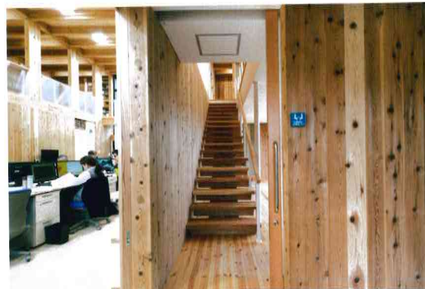
1階の地域交流室内に設置された地元材による階段を見る。富岡の森から切り出した木材のうち、中断面の材料を利用している。地域交流室は、地域の街づくりワークショップや懇親会などが行われ、地域の人がアクセスしやすいように外部に面している。
