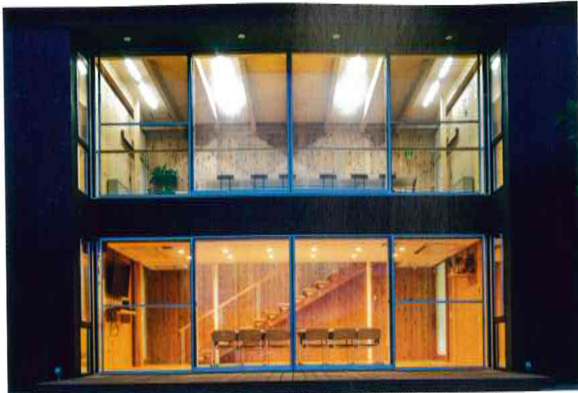
東側から地域交流室。多目的スペースを見る。縦ログ壁を利用して外部に開くような設えとした。
