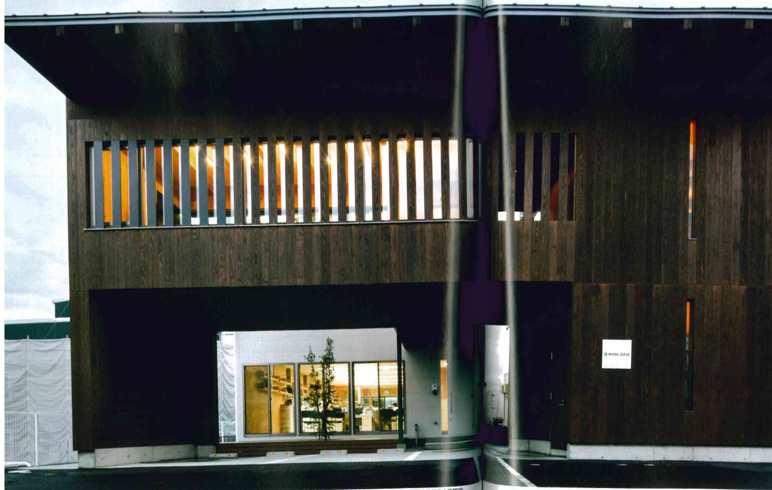
郡山社屋道路側全景。約11mのスパンのピロティを持ち、縦ログによる会議室が浮かんでおり、中庭を介して執務室が見える。準防火地域ではあるが、縦ログにおける準耐火性能の大臣認定により、内外木材現しとすることができた。左側の壁に横ログと縦ログを二重に使ったクロスログを用いている。
