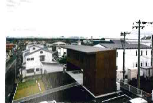
郡山社屋南西側より外観を見る。会議室(通路側)はスギ材による縦ログ、執務室は(南側)はモミ材による縦ログで、会議室のみ内外木材現しである。
