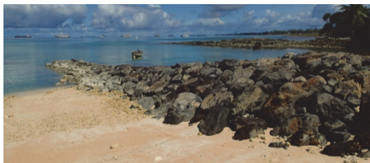
図-12 完成後の突堤
