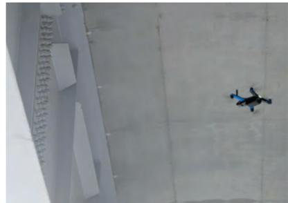
機動性に優れたUAVを活用することで、効率的な調査を行います。機体に搭載された6箇所のカメラ映像により全方位の障害物を検知し自動回避するため、T桁の間など狭窄部でも調査・撮影が可能です。
