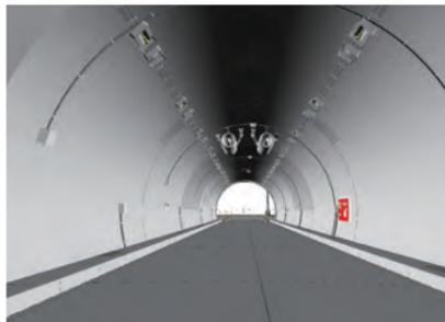
三次元モデルを作成することで、走行シミュレーションを行うことができます。UAV等で計測した点群データと組み合わせることで、走行時の視認性を確認でき、危険箇所を把握することができます。
