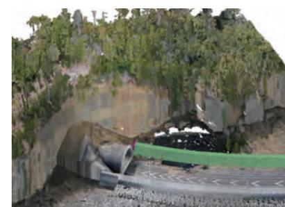
土砂崩落が発生した場合でも、UAV等により三次元点群データを取得することで安全に被災直後の状況を確認し、早急な土砂撤去に移行可能です。点群データから図面を作成し、適確な復旧計画を行います。
