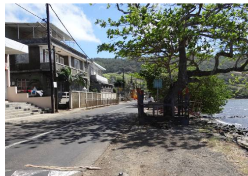
図-2 事業実施前の背後域の状況
