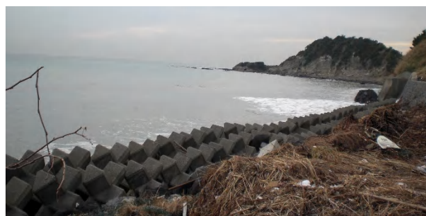
写真-1 消波ブロックの設置状況（平成21年10月撮影）
